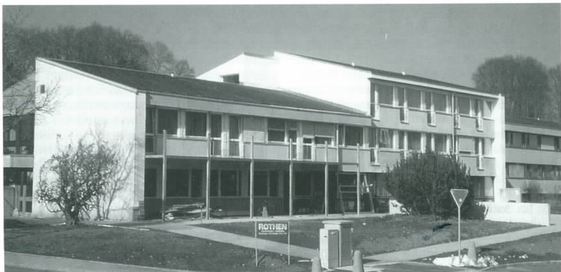
Das renovierte Altersheim Riggisberg, März 1998
